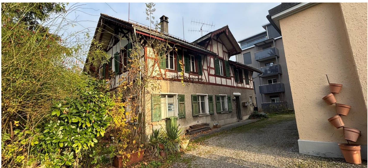
Bild 2: Aussenansicht aus der Bahnhofstrasse
