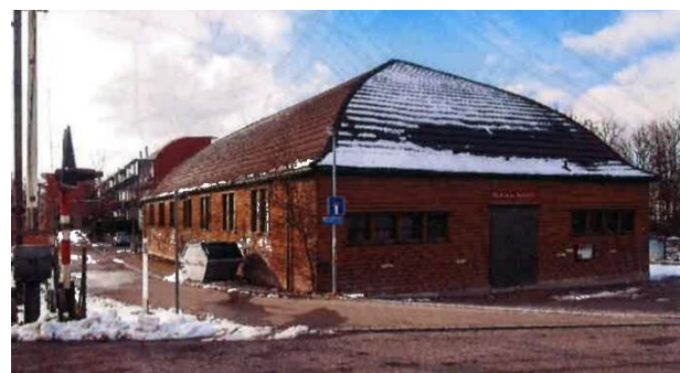
Ansicht von der Asylstrasse vom 11.01.2022
