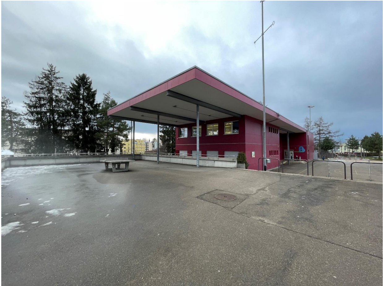
Bild 1: Schulraumprovisorium auf der Schulanlage Walenbach
