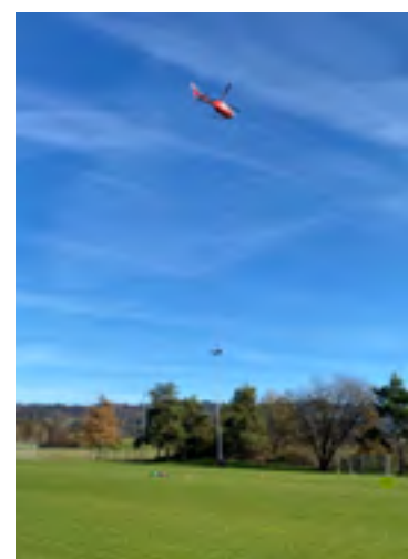
Befestigung des Beleuchtungsmastens auf dem Fussballplatz 4 der Sportanlagen Meierwiesen
