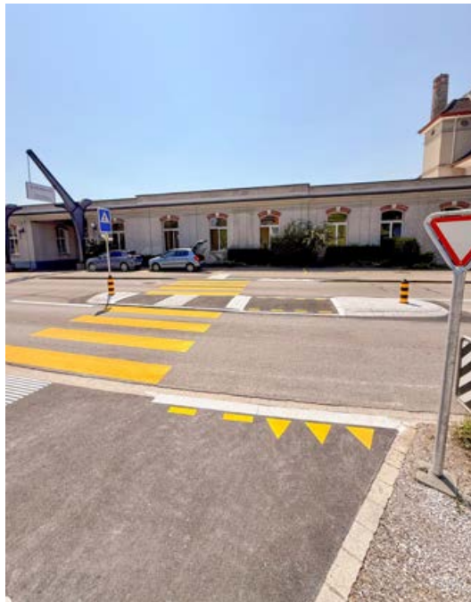
Die 2025 realisierte Veloverbindung bei der Rainstrasse schliesst eine Lücke im Netz und verbindet die kommunale Veloinfrastruktur sicher mit der kantonalen Route entlang der Zürcherstrasse.
