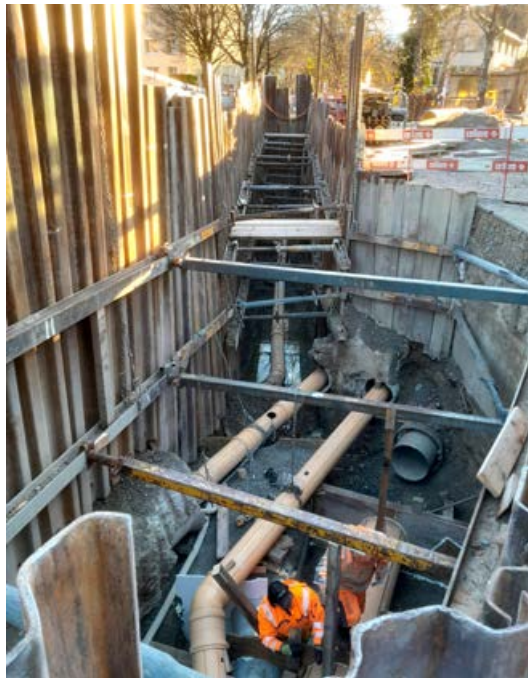
2025 wurden im Rahmen der Erneuerung der Bachtelstrasse viele Bauarbeiten realisiert.
