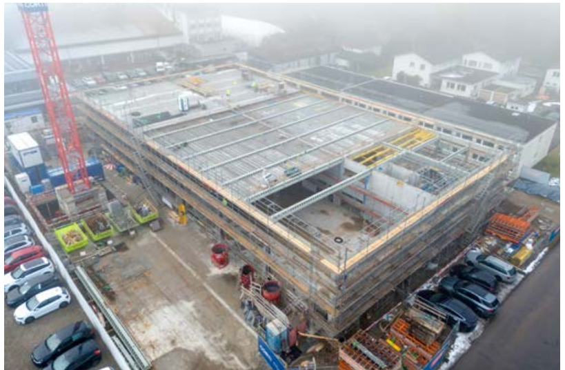
Bauarbeiten für das neue Feuerwehr-, Polizei- und Zivilschutzgebäude
