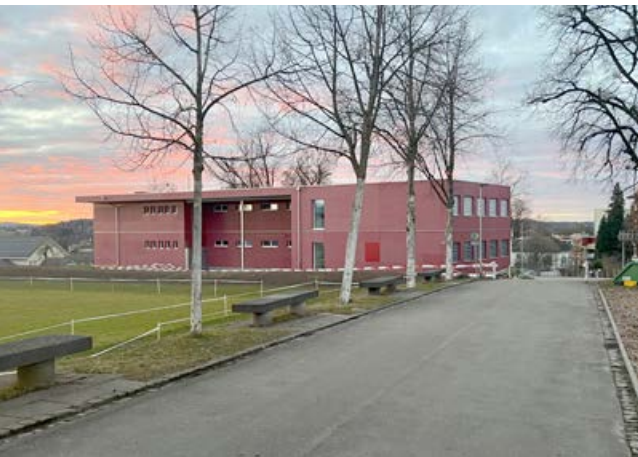
Im Pavillon der Primarschule Guldisloo sind seit Sommer 2025 zusätzliche Klassenzimmer untergebracht.
