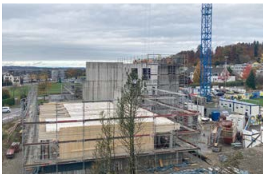
Bauarbeiten beim Primarschulhaus Walenbach
