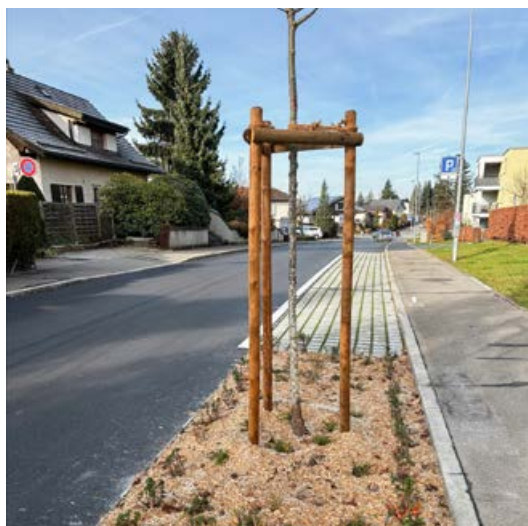
Neu gestalteter Strassenraum an der Preyenstrasse mit erneuerter Deckschicht, angepasster Parkierung sowie neu geordneten Grünflächen und Gehwegen.
