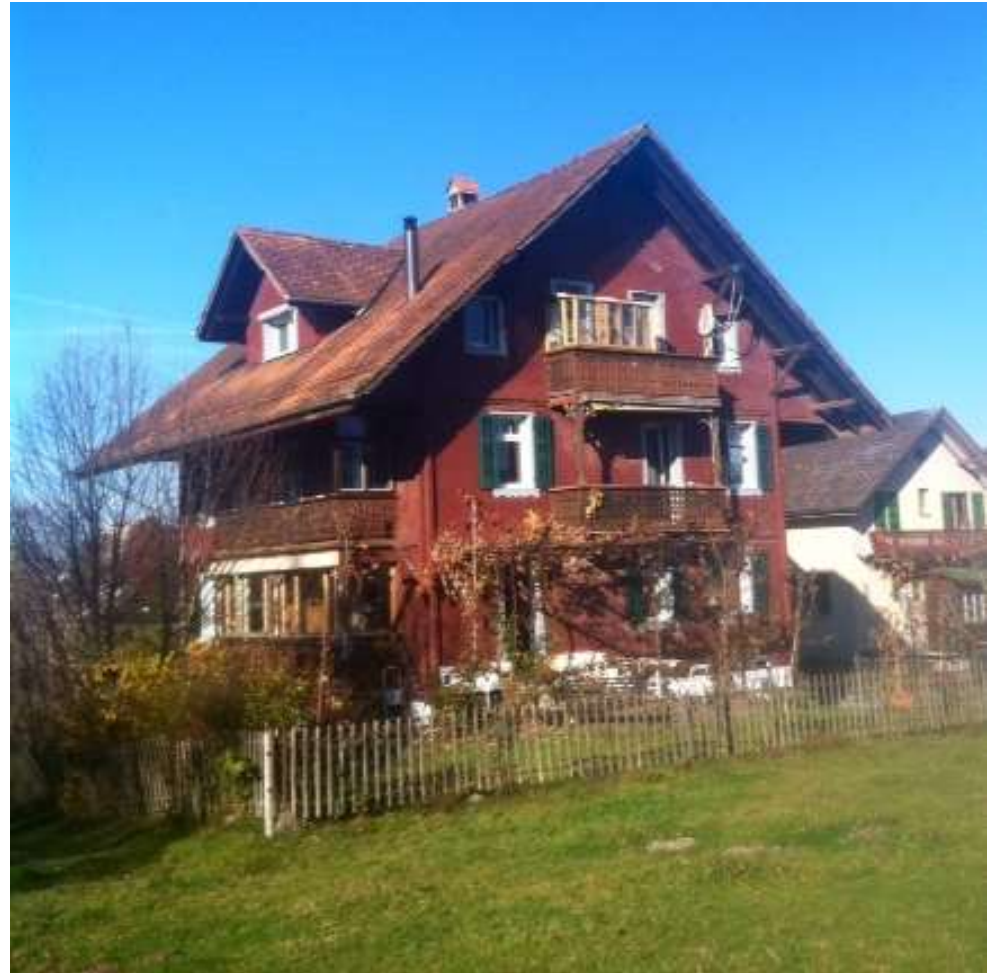
Zustand 2010 vor Dachsanierung, Südansicht
