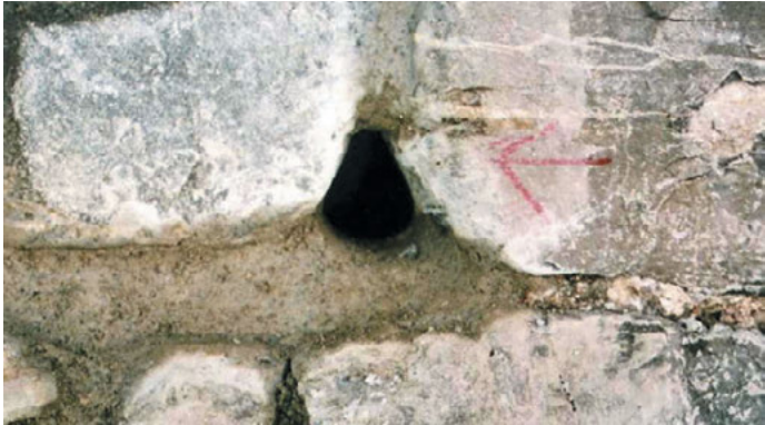
Von Mauerseglern belegte Mauernische. Sie wurde bei der Sanierung sorgfältig erhalten. (Bild: B. Käufeler, Impuls, Thun)
