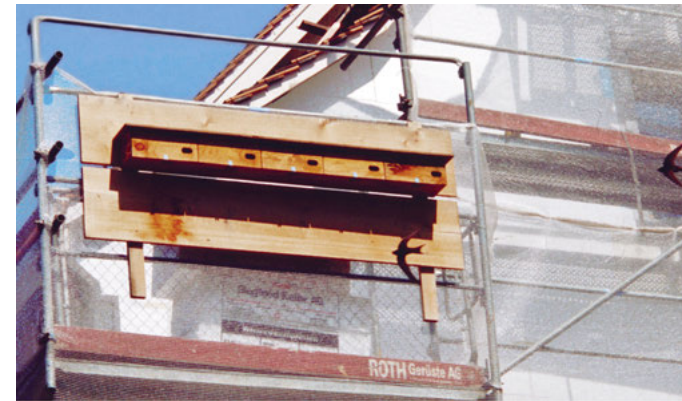
Fünfernistkasten an einem Gerüst.
