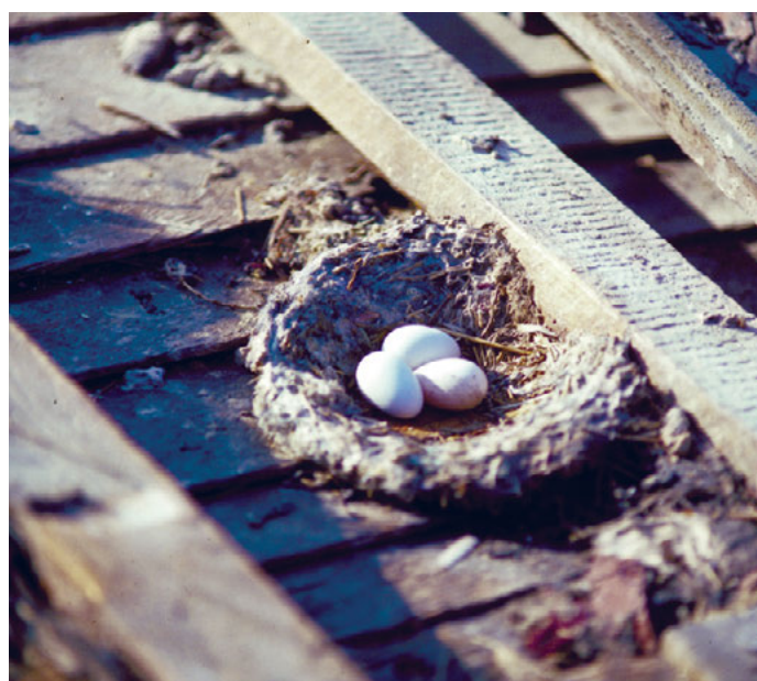
Typisches Mauerseglernest auf einem Unterdach.
