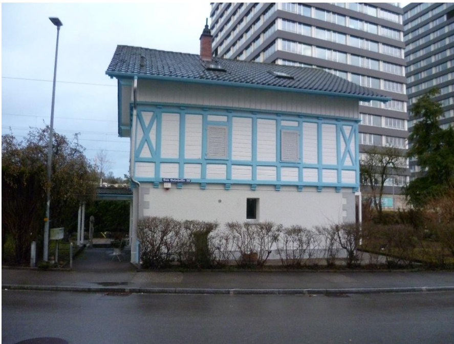
Neuhausen/SH, Nebengebäude der Bahnhofsanlage der Grossherzoglichen badischen Eisenbahn. Bauzeit 1863. Man beachte die Strebenkreuze oberhalb der Brüstungszone der Trauffassade. (Foto Pantli, Februar 2025)
