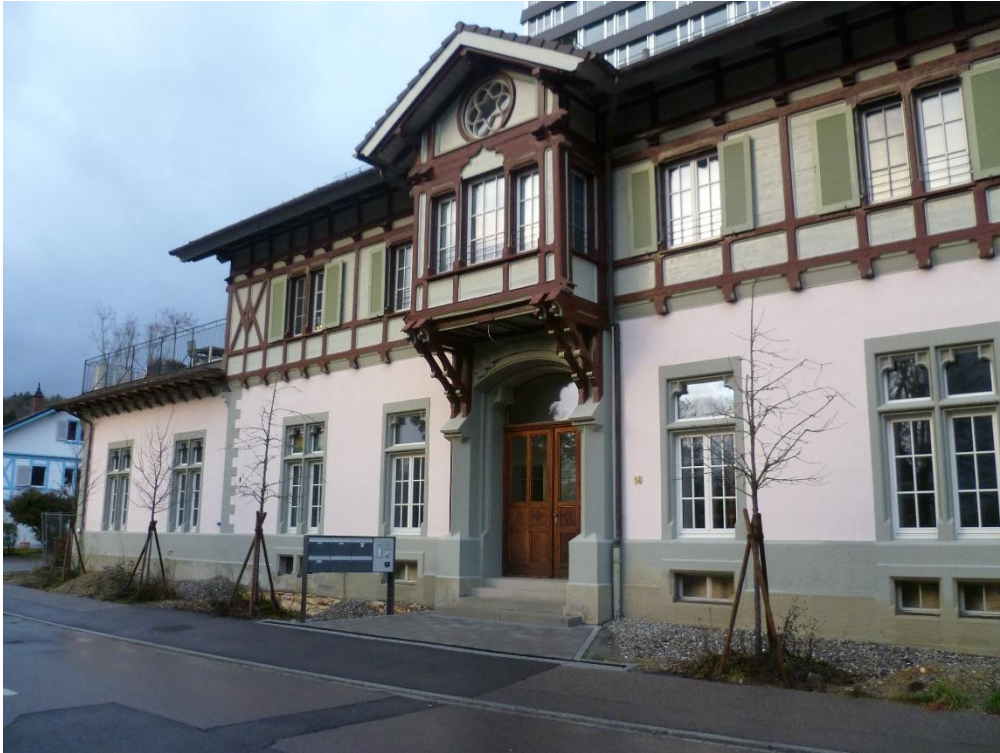
Neuhausen/SH Empfangsgebäude der Grossherzoglichen badischen Eisenbahn. Bau vollendet 1863. Man beachte das Strebenkreuz an der linken Kante des Obergeschosses. (Foto Pantli, Februar 2025)
