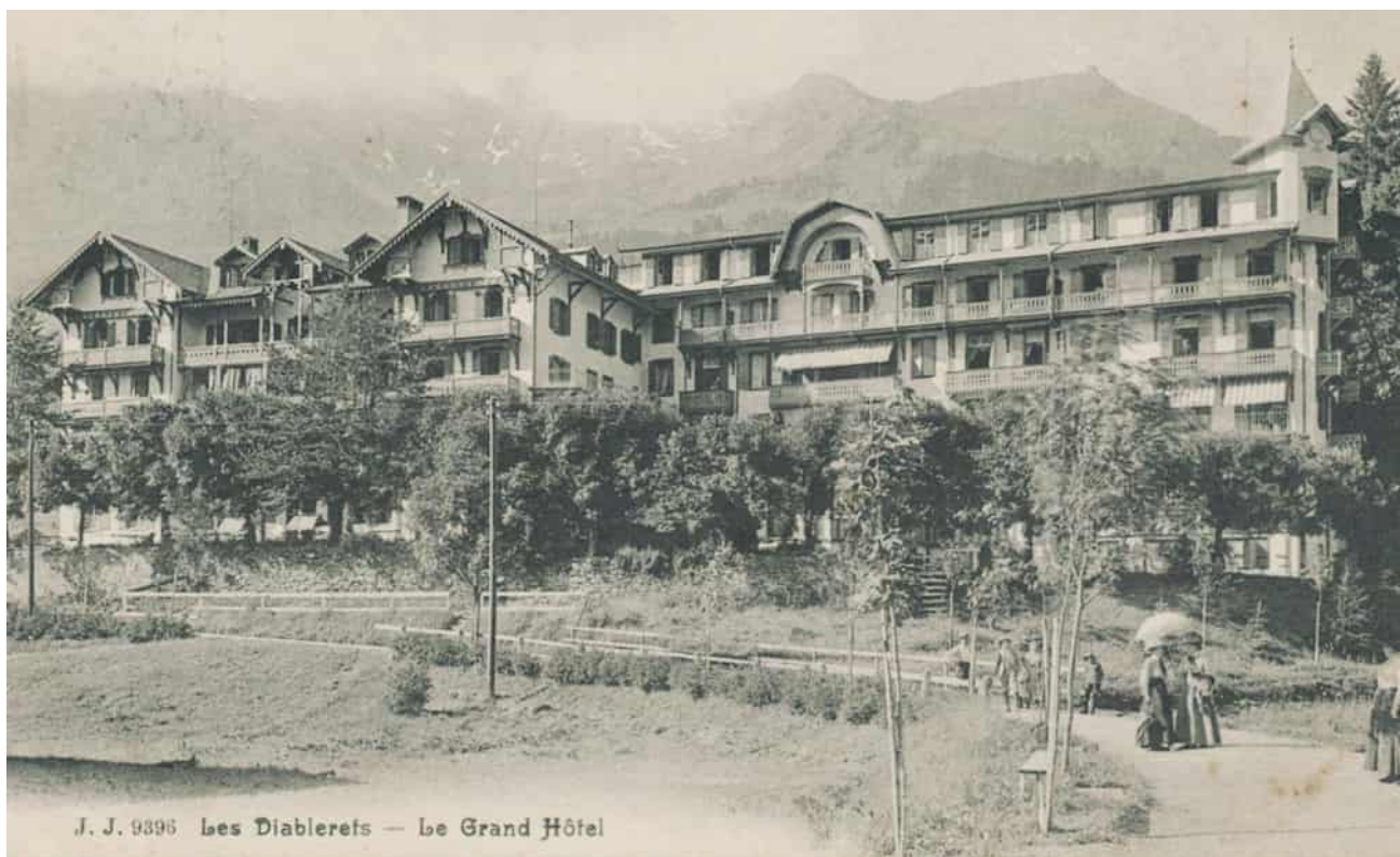
Abb. 94 Grand-Hôtel, «Les Diablerets», 1853 (Aufnahme um 1910 – Kernbau im Holzstil links, Anbau im Grand-Hôtel-Stil rechts um 1900).
