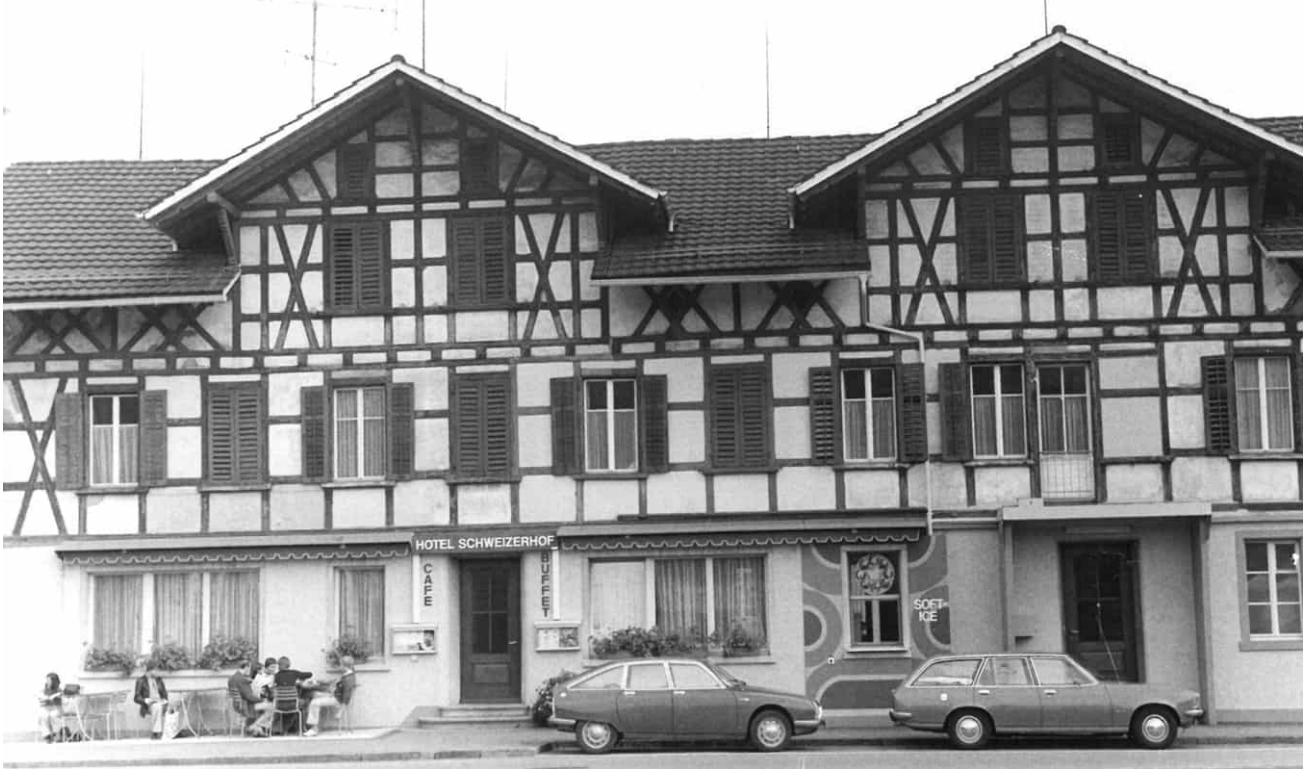
Abb. 44 Fassade um 1972. Die umgesetzten Änderungen an den Fenstern im Gastraum im EG letztlich zwei kleinere Gruppenfenster und Versetzung der Hoteltüre, Abbruch des Balkons.
