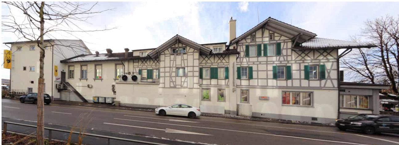
Abb. 58 Ansicht von Norden. Von links Kopfbau (1862, umgebaut 1898, aufgestockt und vereinfacht vor 1960), Saalbau (1898), Kernbau (1862) mit Treppenrisalit, Wartehalle (1904, mehrfach umgebaut).
