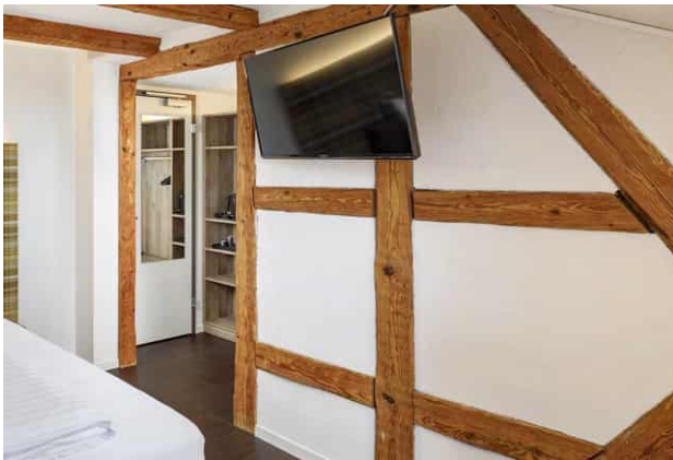
Abb. 76 Hotelflügel, 2.OG, Riegelwand.
