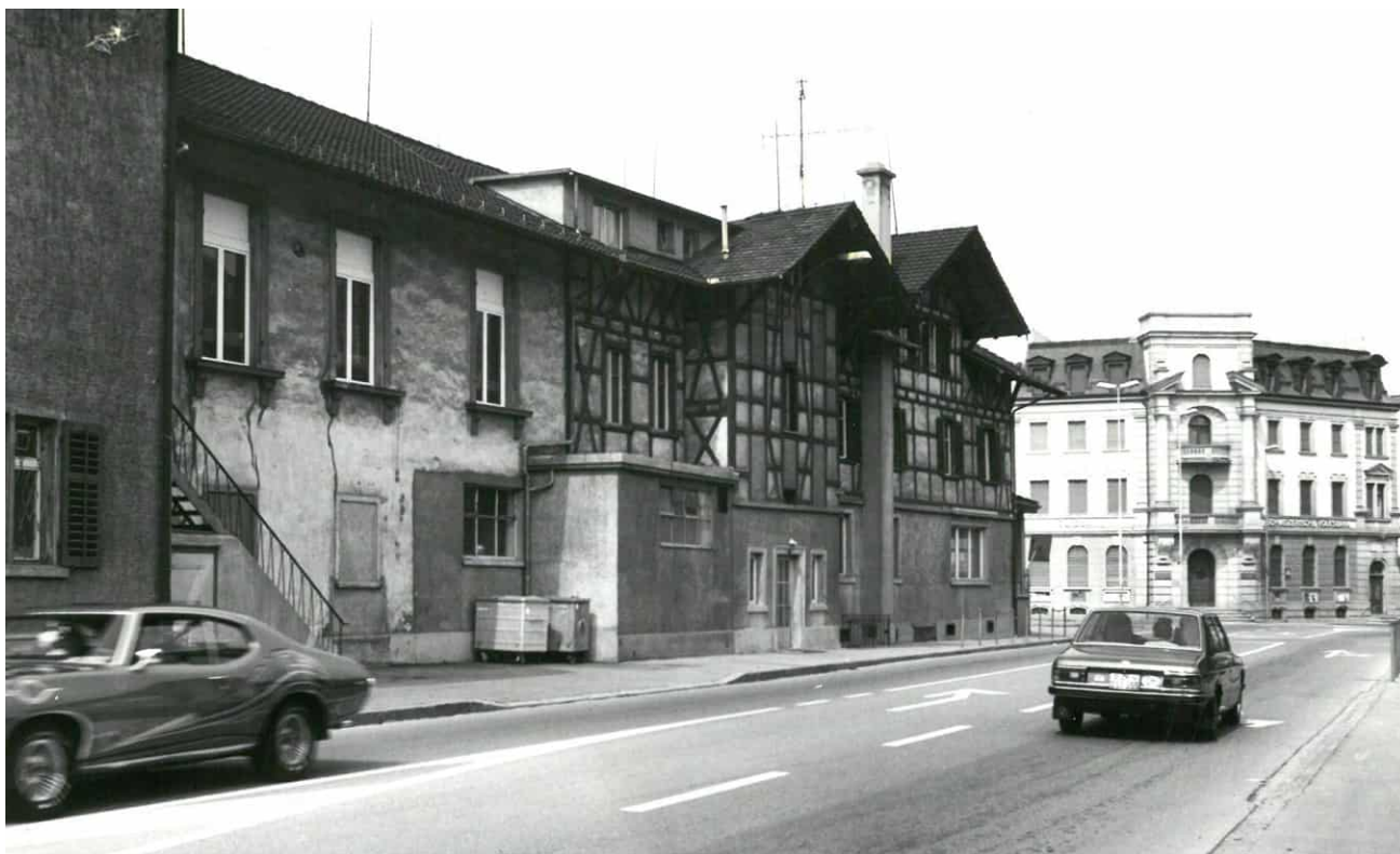
Abb. 30 Nordfassade, 1982. Sockelzone des Hotels überputzt, Küchenerweiterung am Treppenrisalit.
