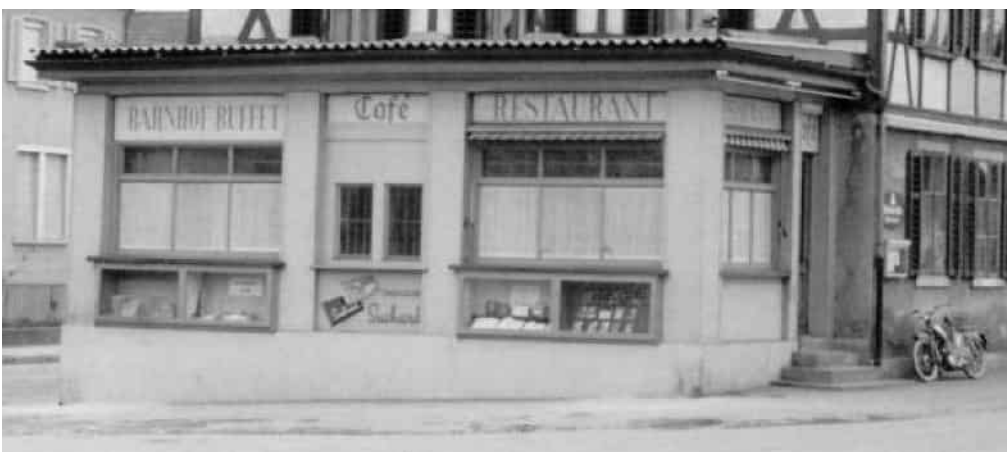
Abb. 55, 56, 57 Westliche Veranda in den Jahren 1905 («Wartehalle»), 1946 und 1962.
