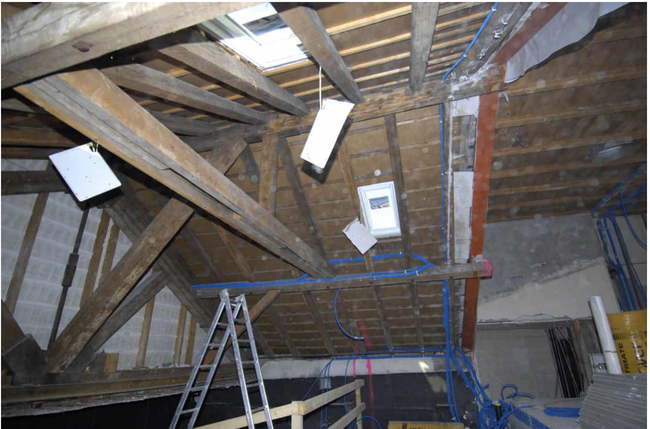
Abb. 48 Obergeschoss des östlichen Kopfbaus und Saalbaus, Ansicht gegen Norden in den Dachstuhl hinein. Entkernung 2009. Rechts bildet sich der Nordgiebel des Kopfbaus von 1898 vor der Aufstockung ab.
