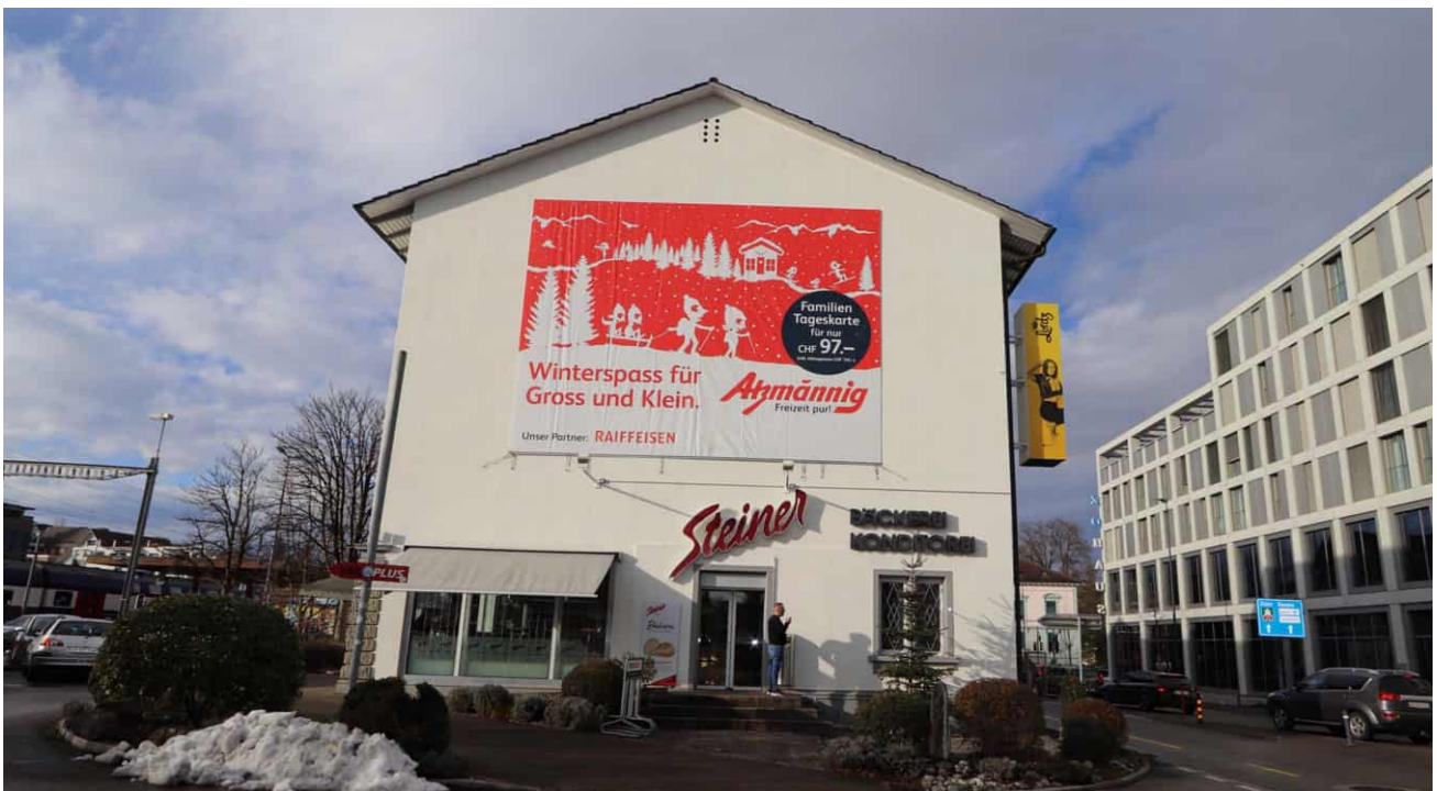
Abb. 61 Ansicht von Südost, Kopfbau. Sockelgeschoss mit rustiziertem Eckpfeiler (Bauphase 1898), sonst später erneuert.
