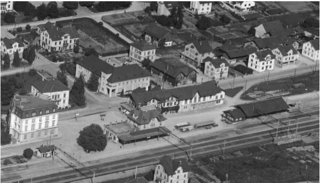
Abb. 24 Der gleiche Ausschnitt, hier von Südwesten, im Jahr 1946. Das EG von Saalbau und Kopfbau des Hotels bereits umgebaut, der südliche Balkon am Hotel im Bau begriffen.
