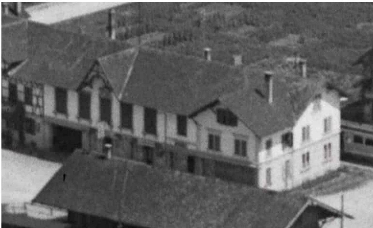
Abb. 63 Ansicht von Süden, Ausschnitt aus Luftbild 1919. Saalbau und Kopfbau von 1898 noch mit bauzeitlicher Dachlandschaft und Fensterpositionen.
