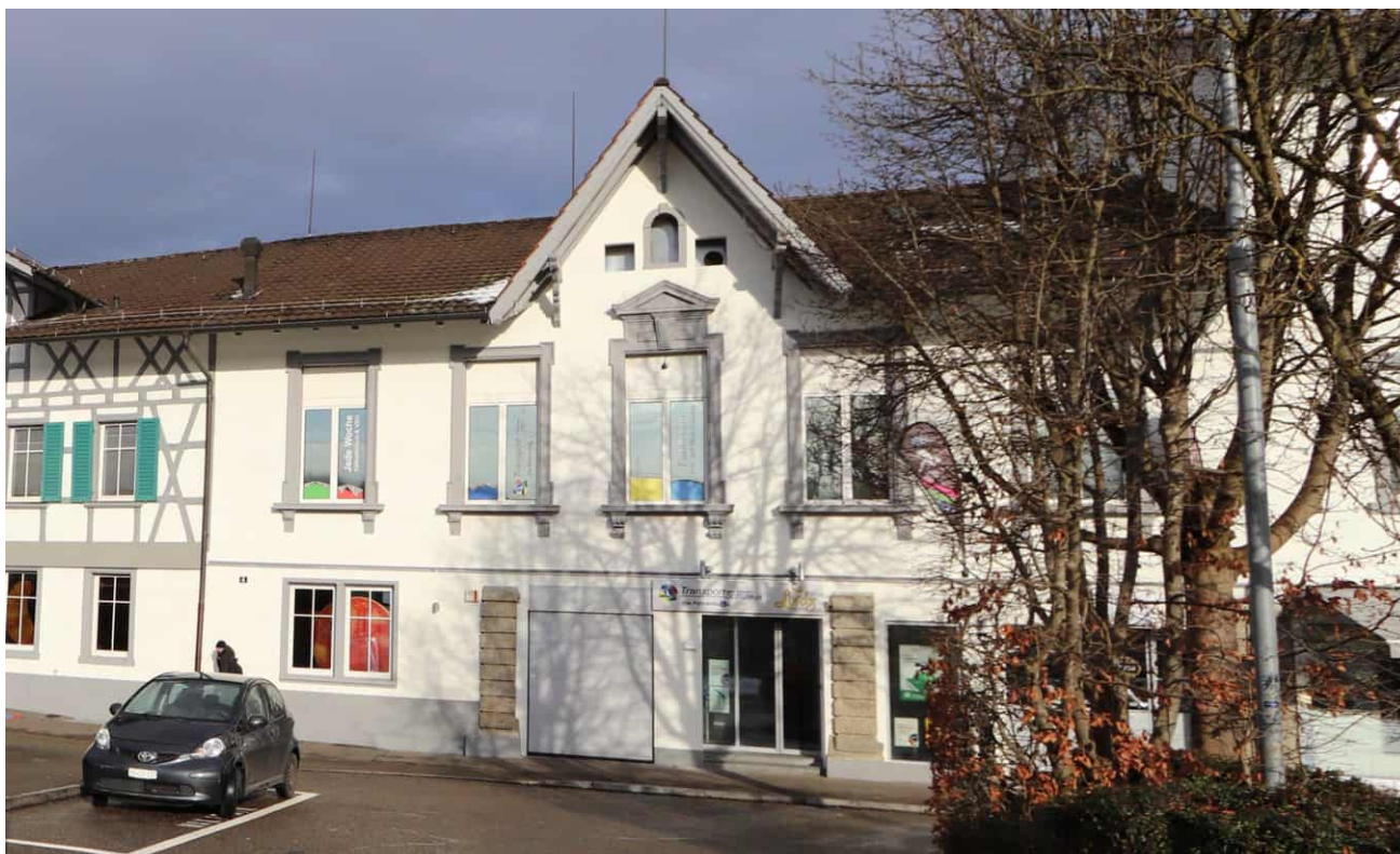
Abb. 62 Ansicht von Süden, Saalbau von 1898 mit Fensterzier und Ziergiebel. Die rustizierten Pfeiler im EG ursprünglich hölzerne Fensterfronten einfassend; das Doppelfenster links von 1945, Vermauerung ehemaliger Durchfahrt.
