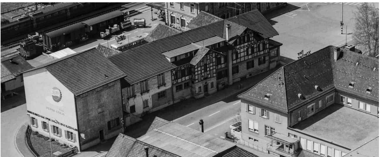
Abb. 27, 28, 29 Luftbilder, 1968. Der Kopfbau 1949 bereits aufgestockt. Die Südfassade des Hotels mit kleinem Balkon im Ausbauzustand 1946. Die Ladenfronten im Saalbau sowie die Sockelzone der Nordfassade am Hotel noch bauzeitlich.
