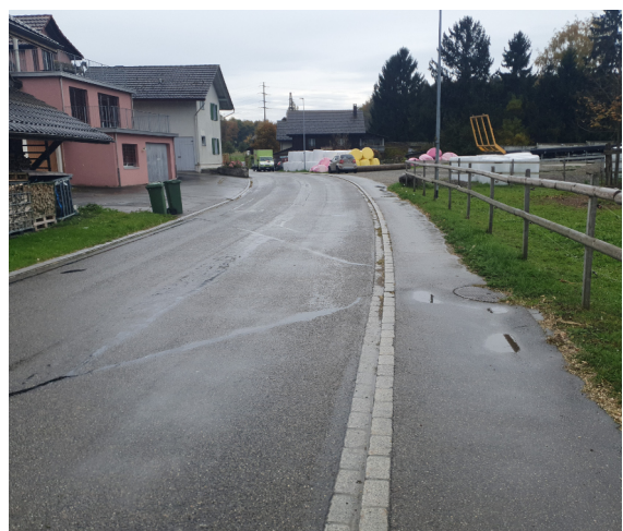
Trottoir mit lokalen Absenkungen
