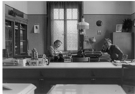
Blick in das Gaswerk-Betriebsbüro
