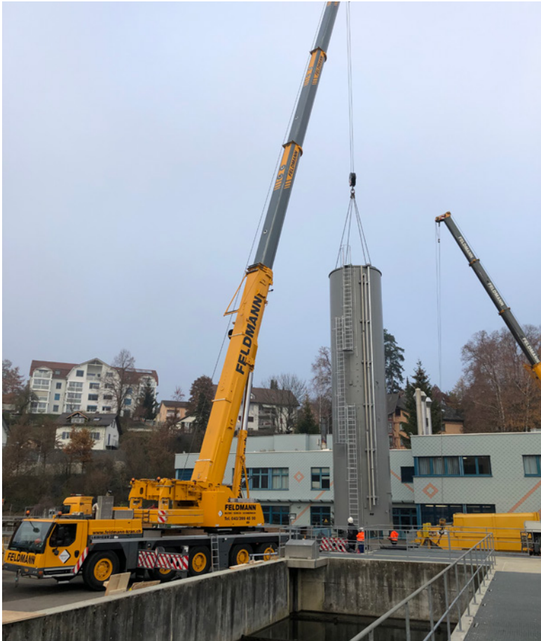
Montage des 18 Meter hohen Silos für die Lagerung der Pulveraktivkohle
