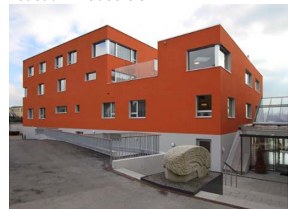
Neubau in Baubereich 2
