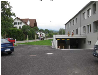
Einfahrt zur Tiefgarage
