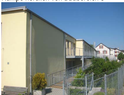
Rampe nördlich von Baubereich 3
