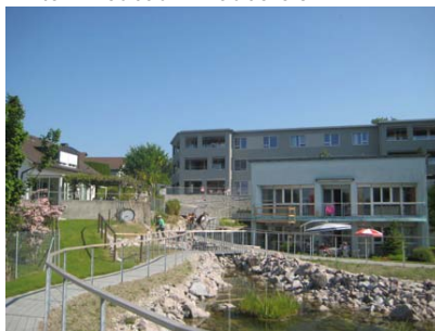
Hinten: Neubau in Baubereich 1
