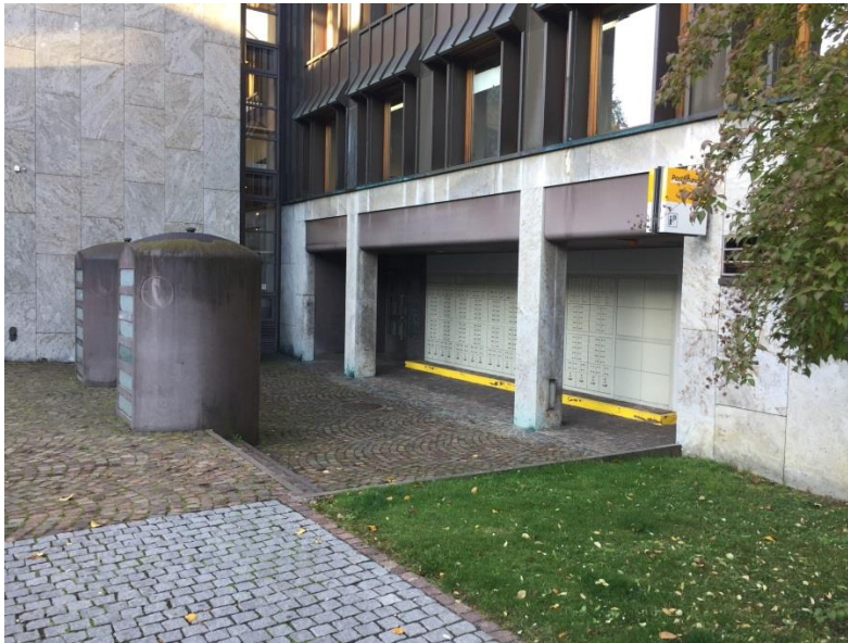
Bild 2: Alte Poststelle von aussen
